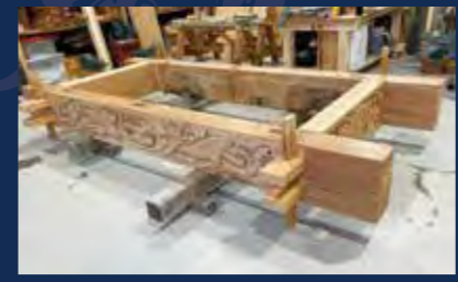
※2 改修中の土呂台
