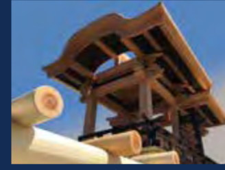
※8 仮付けした屋根を下から見たところ
